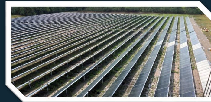
Solarthermie 14.500 m 2 11,5 MW
