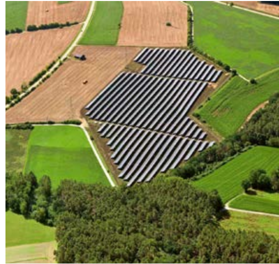
Beispiel aus Bayern: Auf etwa sieben Hektar Fläche befinden sich 8,3 Megawatt Peak Leistung. Hiermit kann der jährliche Stromverbrauch von rund 2.600 Vierpersonenhaushalten gedeckt werden.
